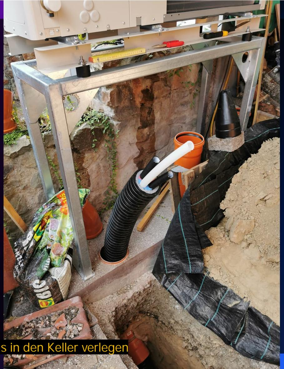
Wärmepumpenrohr von der WP bis in den Keller verlegen
